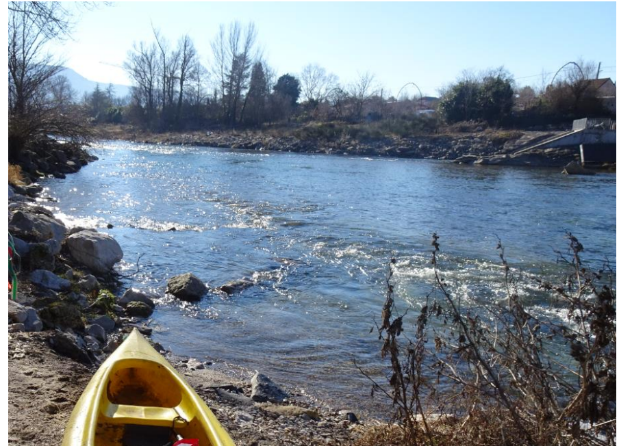
Ci-dessus : Secteur en aval immédiat de la chaussée
